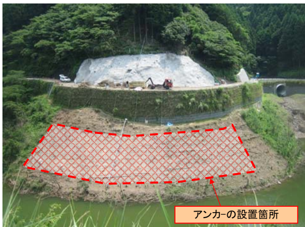
平成22年7月21日 法面整形状況
